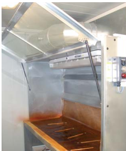
Gefahrstoffarbeitsplatz mit Absaugtechnologie für eine gerichtete Luftströmung in Richtung Absaugleisten in der Rückwand. Mit ca. 0,5 m/s Lüftungsgeschwindigkeit an der 400 mm hohen Eintrittsöffnung bei geschlossener Frontscheibe.
