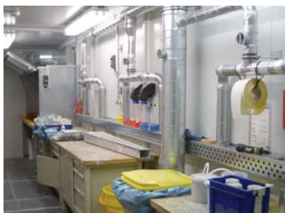
Innenansicht des begehbaren F90-Brandschutz-Containers mit Gefahrstoffarbeitsplatz (im Hintergrund) und abgesaugter Werkbank mit Abluftverrohrung.
