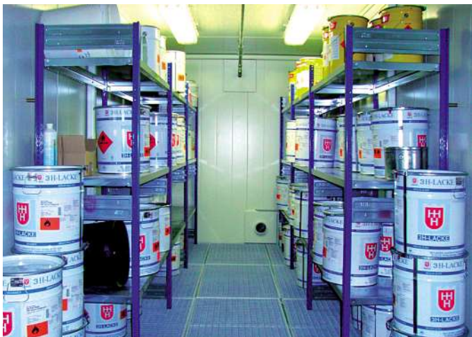
Bild 5: Geordnete Lagerung der Gefahrstoffe im Brandschutzcontainer.
