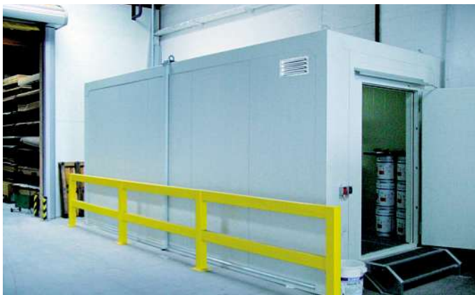
Bild 4: Aufstellung des Brandschutzcontainers in der Warenannahme.
