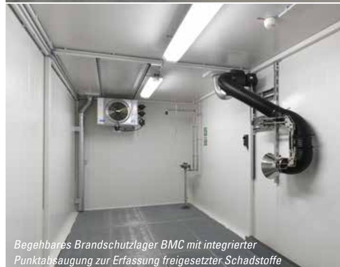
*Begehbare Brandschutzlager BMC mit integrierter Punktabsaugung zur Erfassung freigesetzter Schadstoffe*
