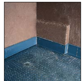
Stahlblechaufkantung sichert das Auffangvolumen
