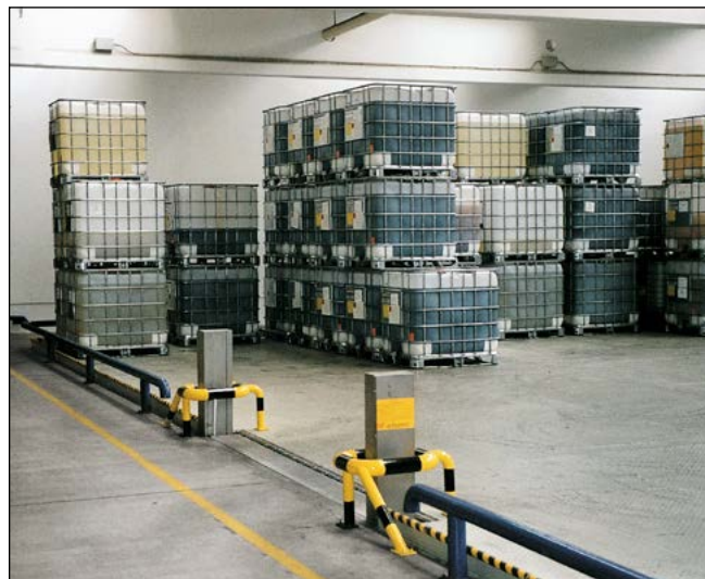
Raumauskleidung mit Tränenblechen und umlaufender Stahlaufkantung. Das Klappschott ermöglicht rampenfreies Einfahren und bietet im Gefahrenfall die notwendige Sicherheit!
