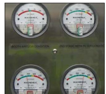
Magnehelic-Differenzdruckmesser mit gekennzeichneten Bereichen für einen sicheren Betrieb
