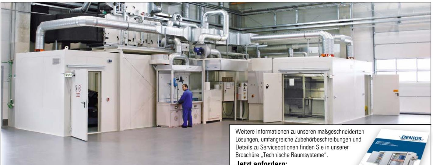
**Gesamtanlage inklusive Lüftungstechnik und separater Absauganlage für Mischvorgänge vor dem Lager**
