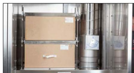
Filterzellen in der Rückwand eines Freiarbeitsplatzes
