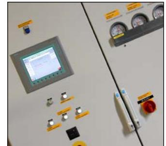
Hauptbedienfeld mit Siemens S7-300-SPS und 10"-HMI-Bildschirm
