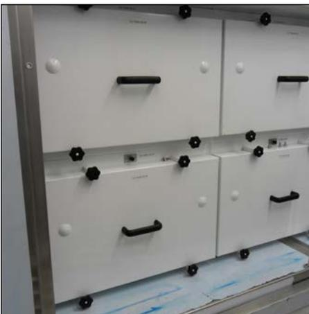
Filtergehäuse für einen kontaminationsfreien Filterwechsel
